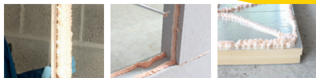
Verlijmen van gipsplaten
